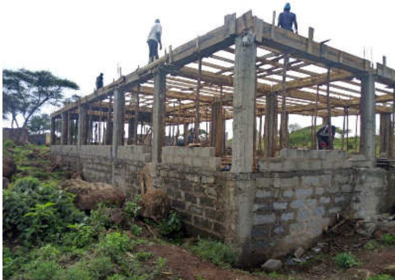
Die Bauarbeiten am Haus der Gemeinschaft im Süden Kenias.
